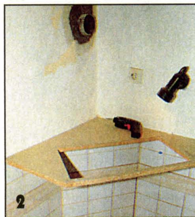
2 Поверхности вокруг выступающей из канала трубы оштукатуривают. Основание кожуха крепят шурупами к диагональной опоре.
