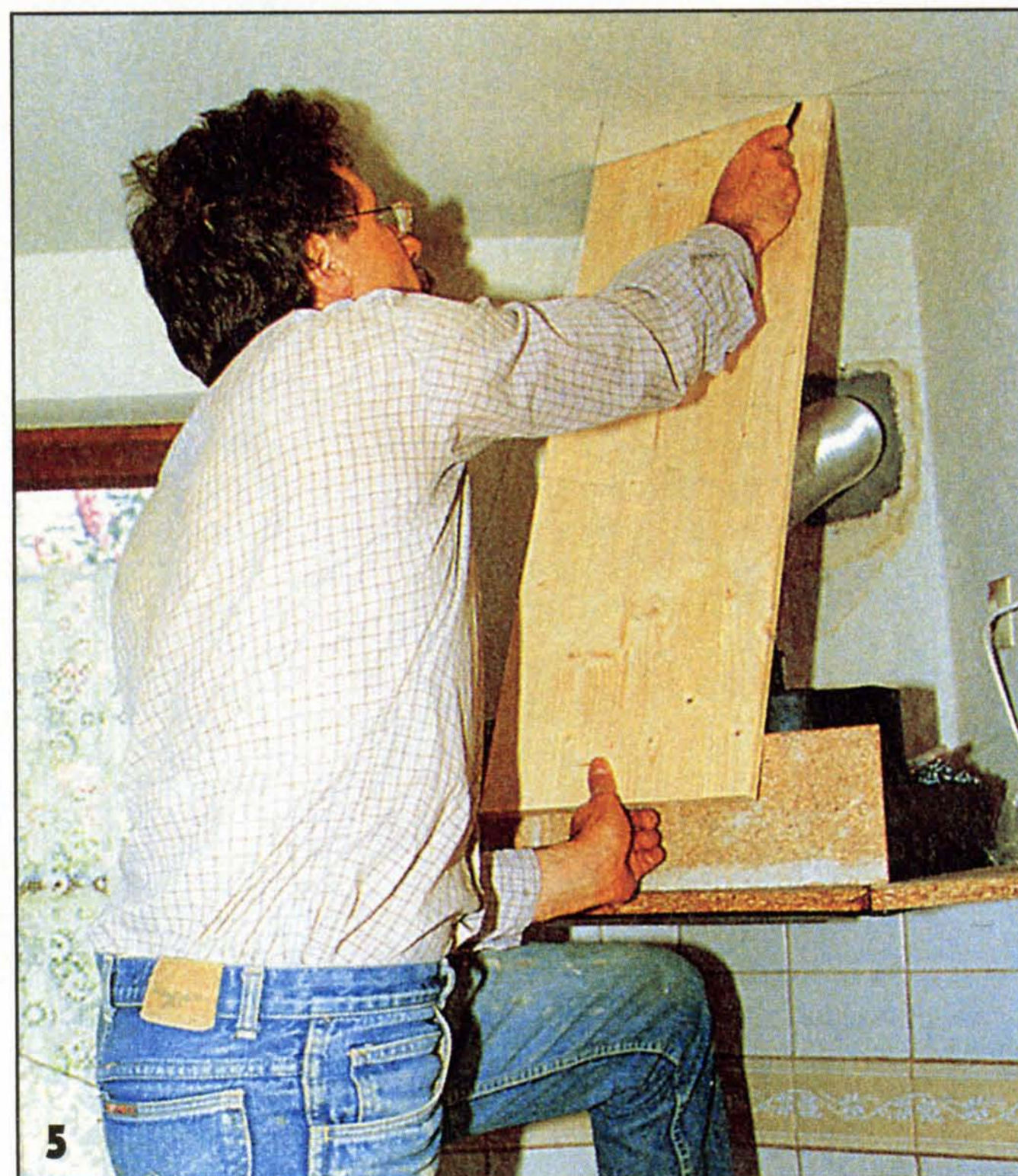
5 На потолке помечают линии для крепления к нему несущих деревянных брусков, к которым потом будут прикреплены выкроенные из ДСП боковые накладки колпака.
