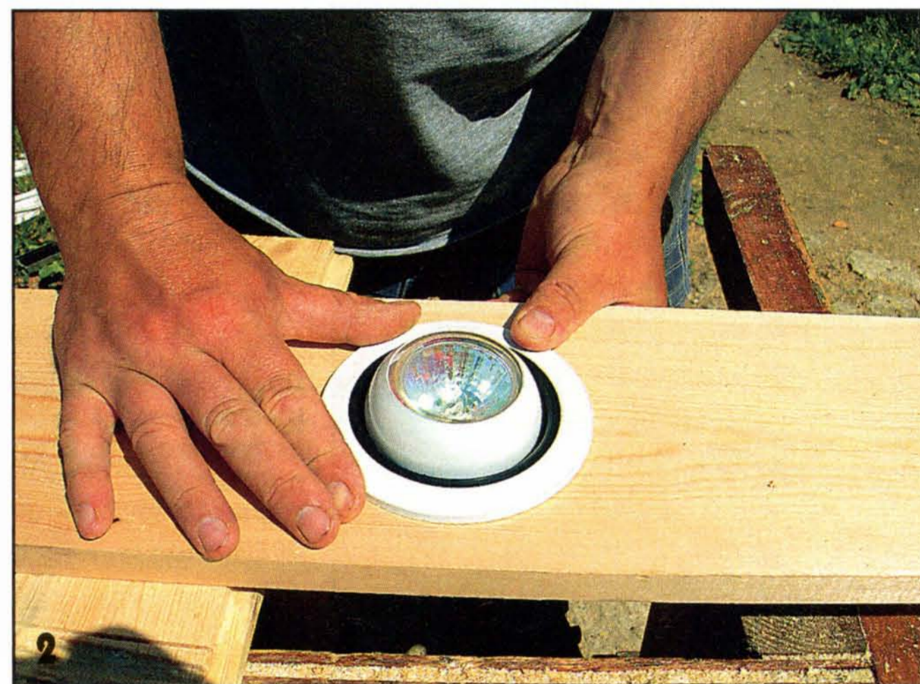
Выпилив отверстие лобзиком, примеряем, как встаёт в него светильник.
