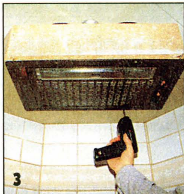
3 Привинтив к основанию вытяжной блок, обрамляют его полосами из ДСП.
