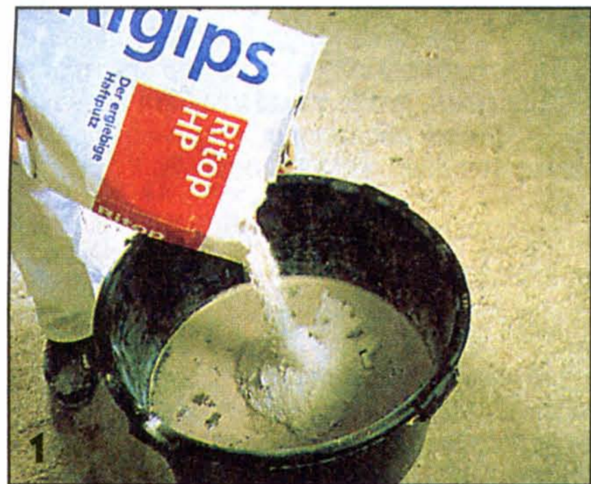
Гипсовую штукатурную смесь засыпают в ведро, наполненное расчётным количеством чистой воды.
