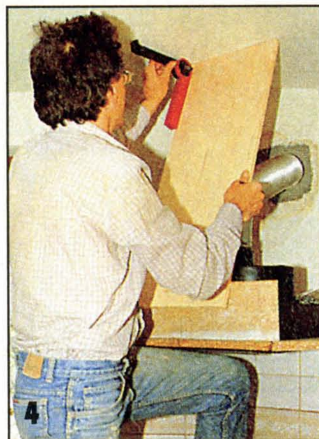
4 С помощью вспомогательной доски и малки определяют угол наклона боковых стенок обшивки колпака.
