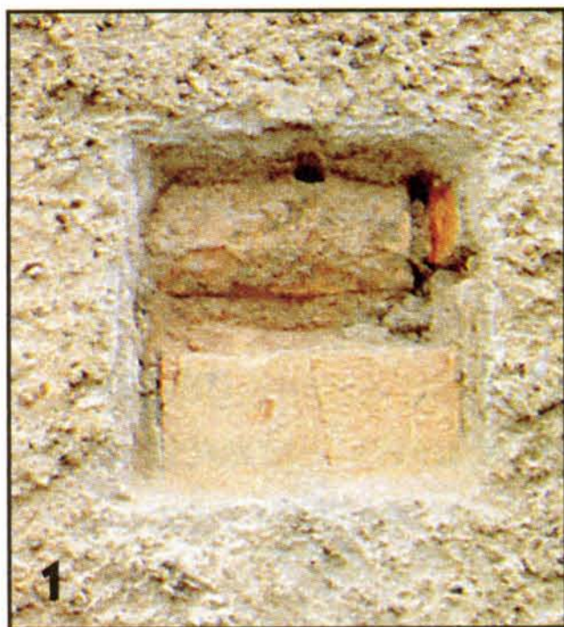
1 Контур будущего вытяжного канала на оштукатуренной стене сначала прорубают зубилом.
