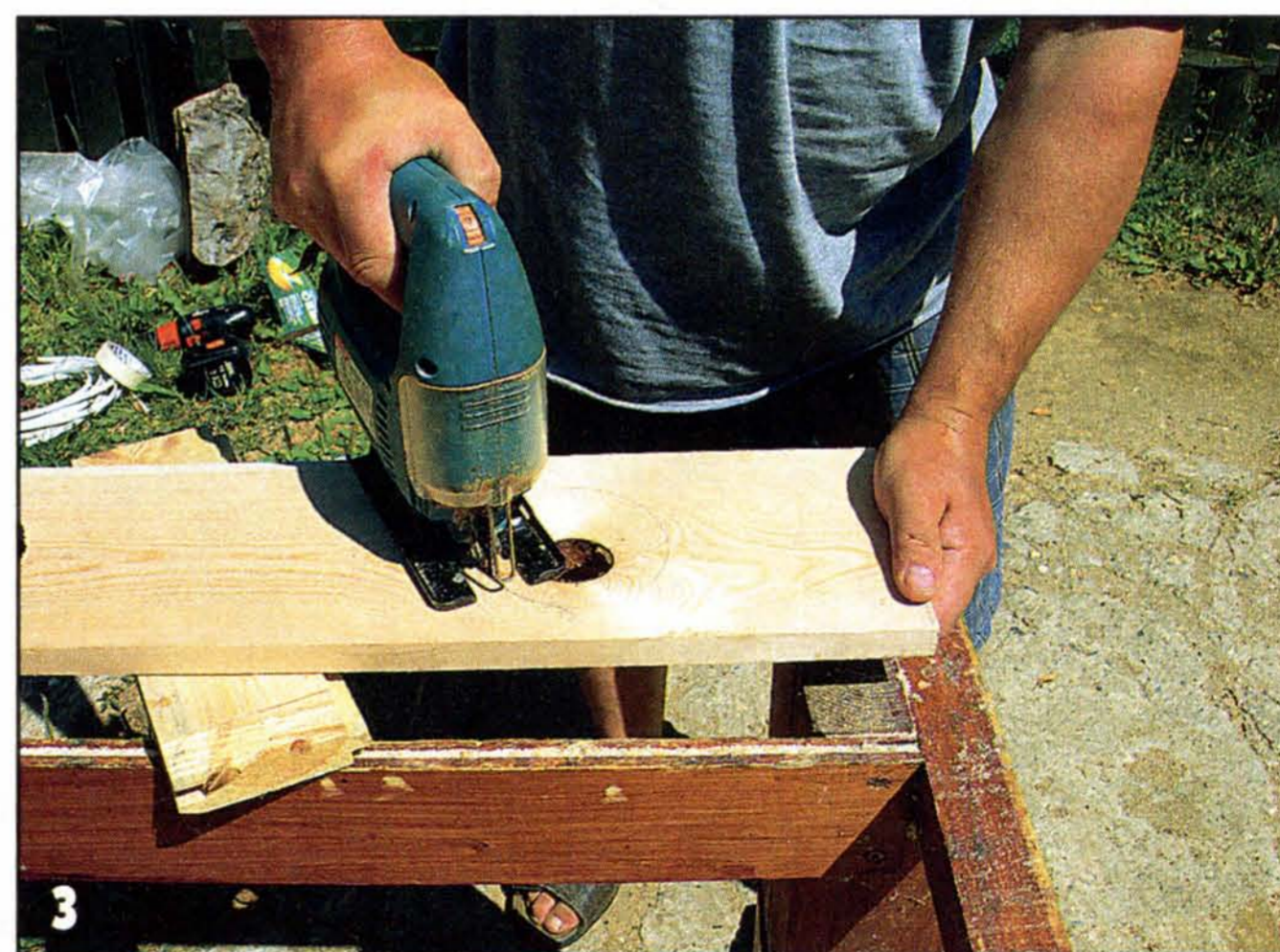
Выпиливаем остальные «лунки» для светильников.
