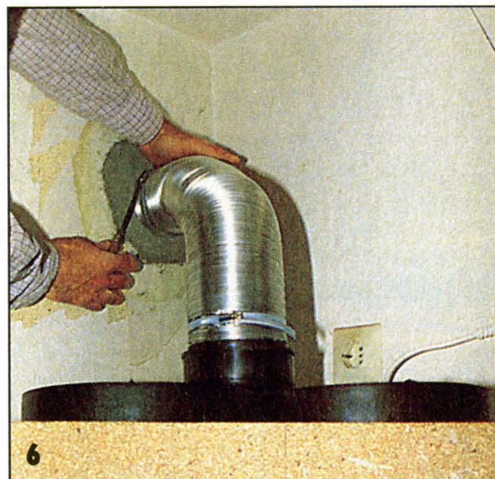
6 Гибкую трубу воздуховода крепят с помощью хомутов к вытяжному блоку и вставленной в канал телескопической трубе.
