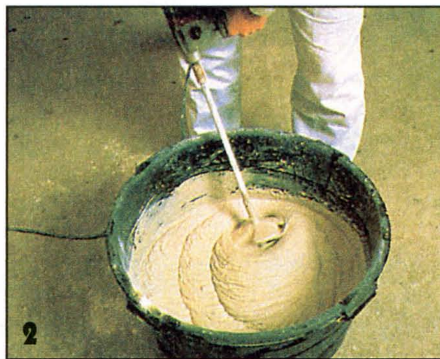
Компоненты раствора тщательно перемешивают до полного исчезновения комочков.
